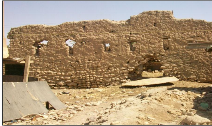
(الصورة - ٣) الجدار الجنوبي للديوان
